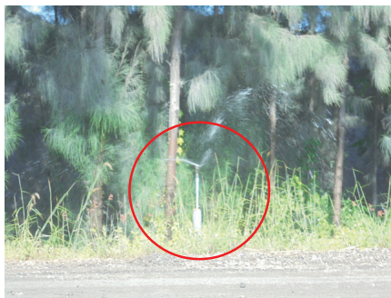
รูปที่ 2-17: ระบบสเปรย์น้ำของโรงโม่หิน
